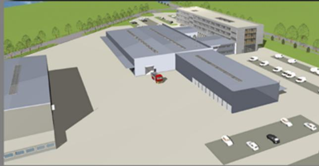
Passend zum Betätigungsfeld von MTEnergie im Bereich der Erneuerbaren Energien ist das Energiekonzept wie auch die Bauweise und Architektur des neuen Firmengebäudes auf Energieeffizienz und Verbrauchsoptimierung ausgerichtet. Alle Gebäude sind mit einem deutlich besseren Dämmstandard und einer höheren Luftdichtheit ausgerüstet als in der Energieeinsparverordnung (EnEV) vorgesehen. Dies gewährleistet langfristig einen energieeffizienten und kostengünstigen Betrieb.
