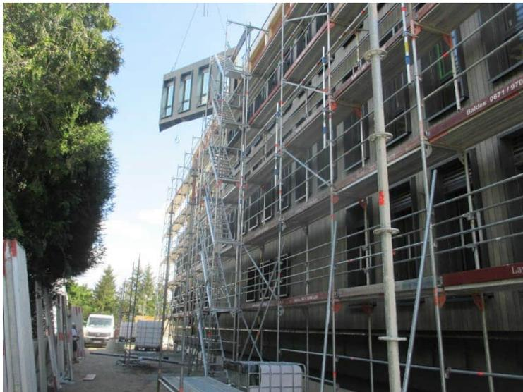
Abbildung 11 Baustellenfoto Montage Fassadenelemente
