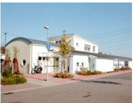
Kindergartenneubau Eggenstein mit Erdwärmeheizung, 2001
