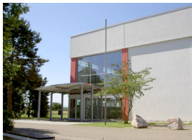
Sanierung und Modernisierung Sporthalle Eggenstein 2004-05
