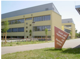
Sanierung und Modernisierung Grund- und Hauptschule Eggenstein mit großen Solarkonzept 2005-2008
