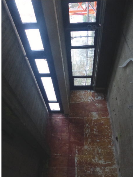
Fotos Klassenraum Sanierungsphase
