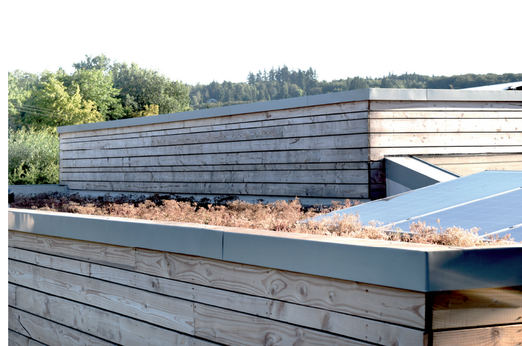
_dachebenen mit dachbegrünung und PV
