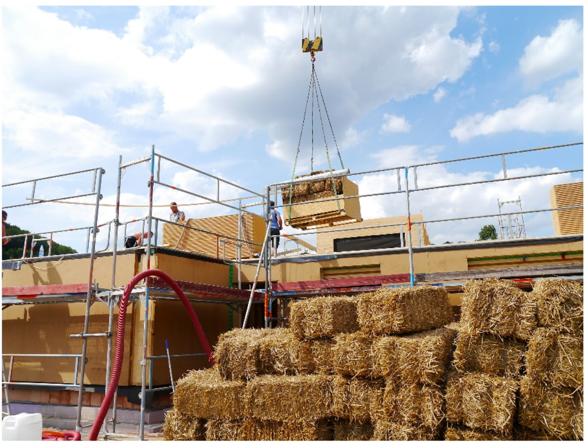
Strohballen als Wärmedämmung
