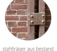
stahlträger aus bestand für neue metallfassade
