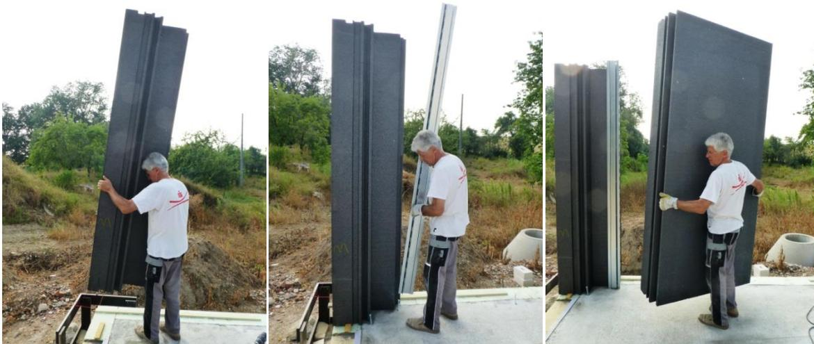
Dämmstoff-Eckelement setzen    Stahlprofil formschlüssig einfügen    nächstes Wandelement fügen
