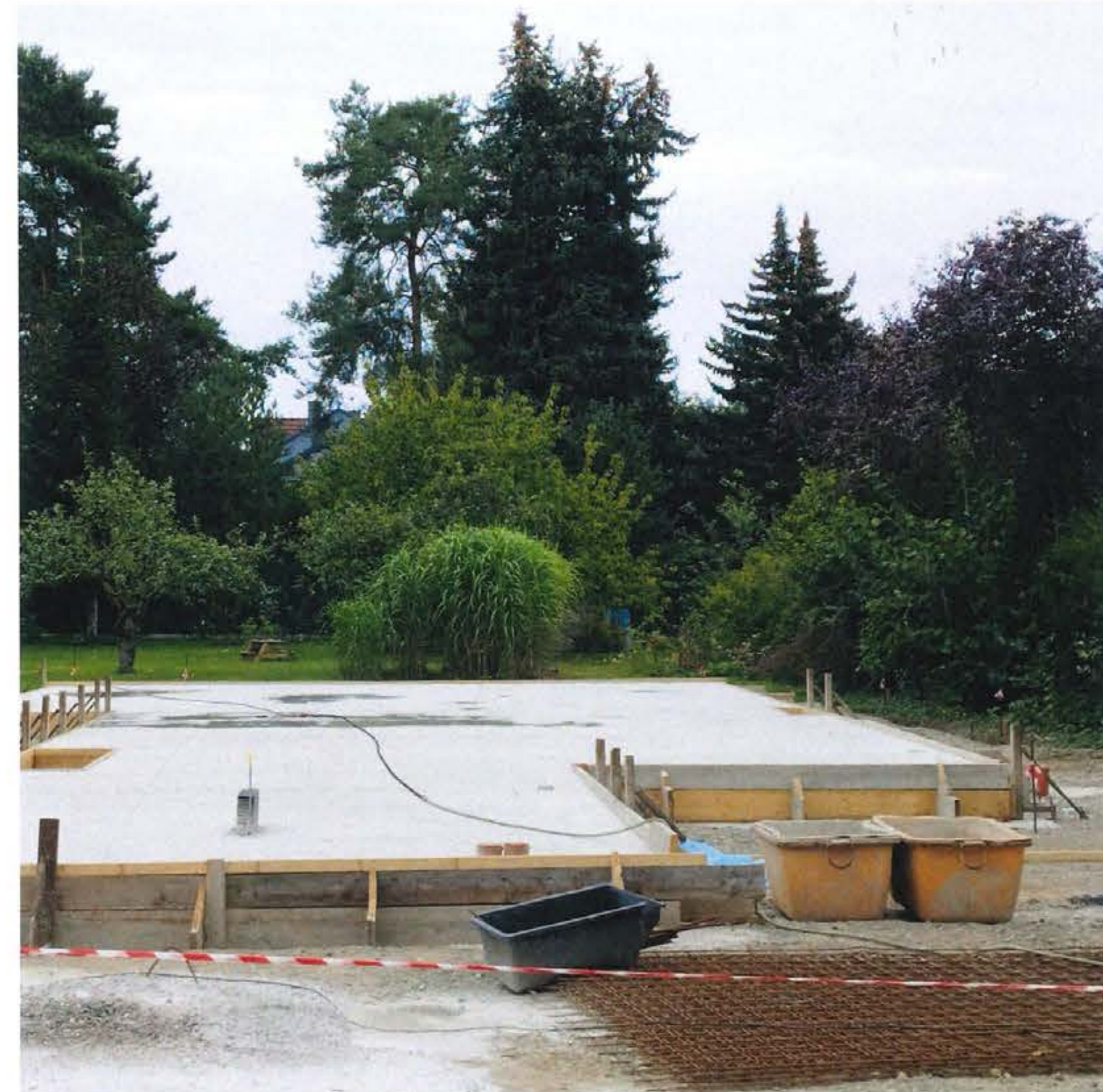
Jedes Haus bedeutet einen hohen infrastrukturellen Aufwand. Neben dem Anschluss an die Strom- und Wasserleitungen erfolgt auch eine Erweiterung des Straßennetzes.
