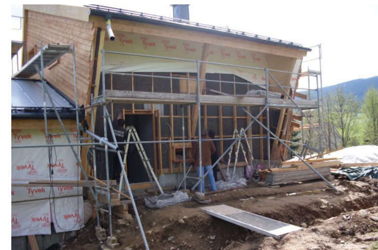
Einbringen der Seegrasdämmung an der Nordfassade
