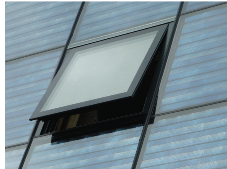
mit den Kollektoren bündiges Dachflächenfenster
