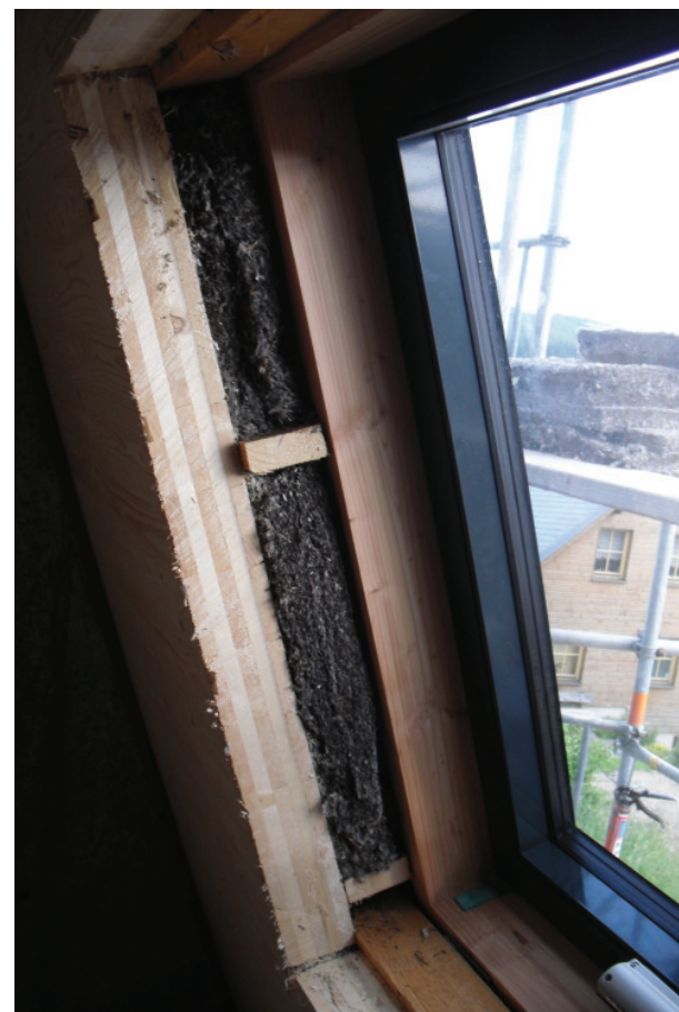
Seegrasdämmung der Dachkonstruktion
