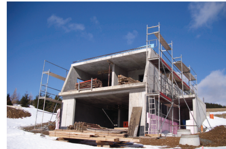
Stahlbetonsockel von EG und OG im Rohbau
