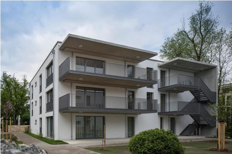
Zimmer mit französischen Fenstern , Balkone und Fluchttreppenanlage in Sichtbeton mit Dauerholzauflage, alle Fenster in Holz- Alukonstruktion , Geländer in Stahl, Oberflächen Metall in Glimmerfarbton DB 703 .
