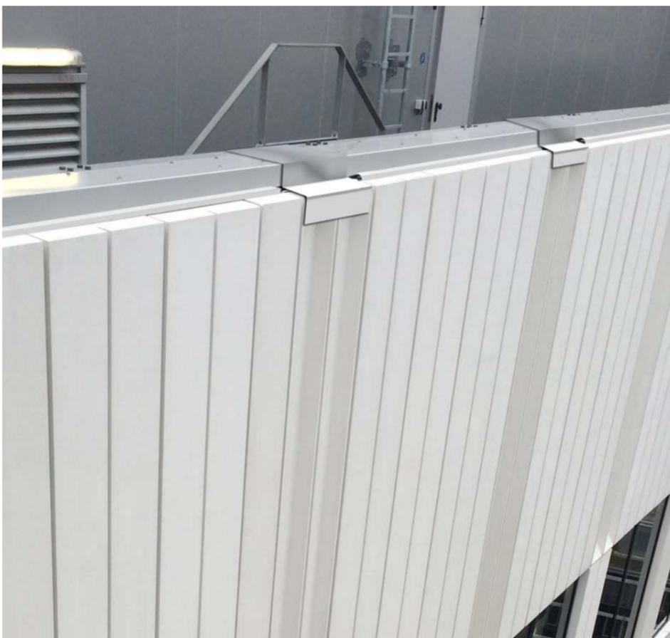
Visualisierung des Aufnahmeprofils / Montageblende
