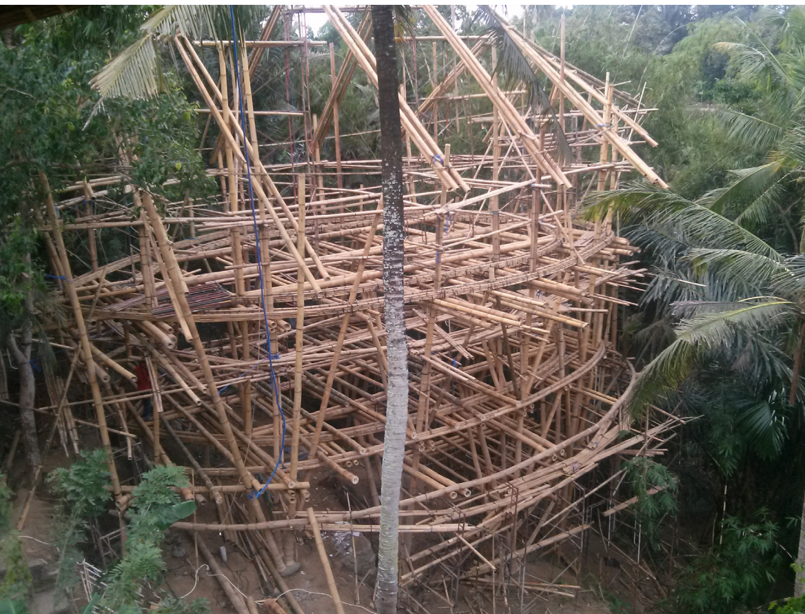
Konstruktion Green School Gebäude auf Bambus-Stahlbetonfundamenten, Bali
