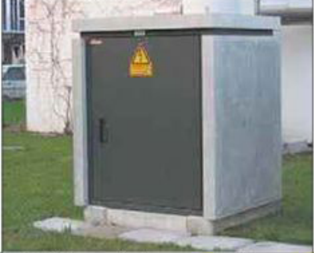
Trafohäuschen aus Sichtbeton
