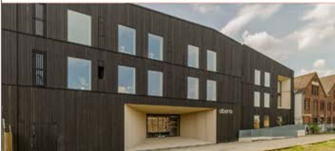
Gewerbebau / Fensterbau Cibaria Bäckerei
