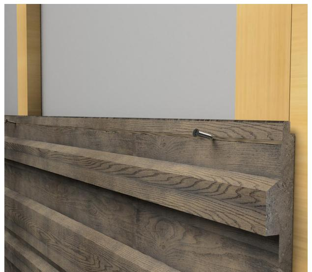
Nachdem die erste Reihe von Paneelen verlegt wurde, kann die zweite Reihe von Paneelen darauf verlegt werden, wobei die Nut die Feder des vorherigen Paneels überdeckt. Prüfen Sie die Paneele nach jeweils 4/5 Paneelen mit einer Wasserwaage, um sicherzustellen, dass die Paneele gerade stehen, und passen Sie den Abstand zwischen den folgenden Paneelen bei Bedarf entsprechend an.
