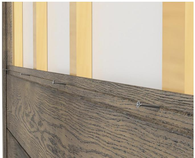
Nachdem die erste Reihe von Paneelen verlegt wurde, kann die zweite Reihe von Paneelen darauf verlegt werden, wobei die Nut die Feder des vorherigen Paneels überdeckt.
