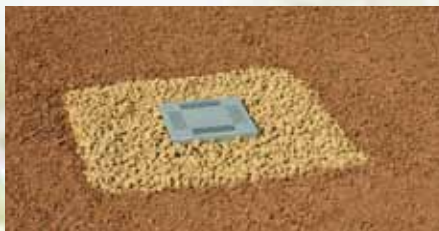
MOGAT Substratschicht Für die Bepflanzung vorbereitet.
