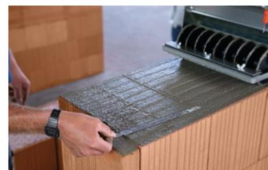
Ggf. zusätzliche Lagesicherung mit Flachstahllanker.
