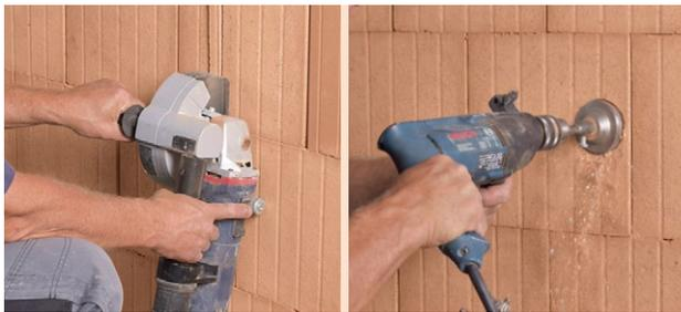
Schlitz und Kronenbohrung für Elektro Dosen
