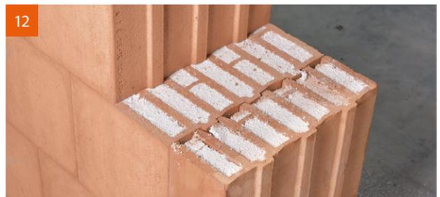
12 Der Ausgleichsziegel ist wärmebrückenfrei versetzt.
