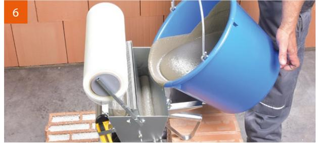
6 Befüllen der V.Plus®-Walze mit Dünnbettmörtel.
