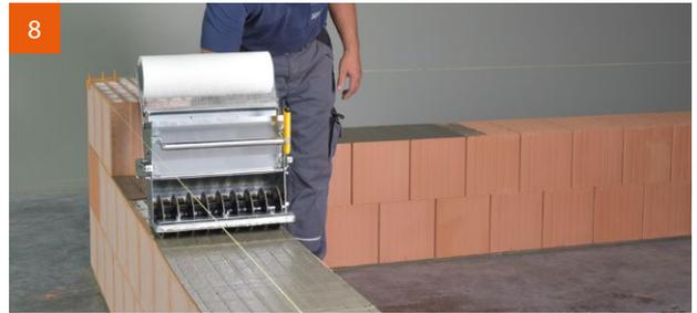
8 Walzen im Schritttempo und Versetzen gleichzeitig.
