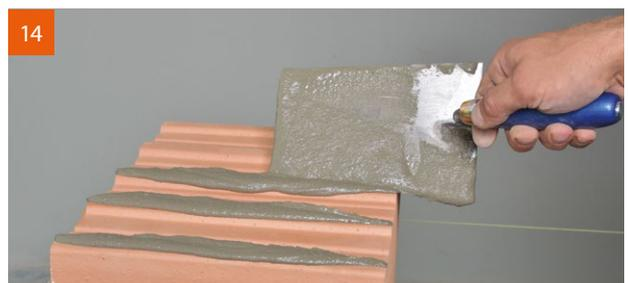
14 Eckanschluss: Mörtelauftrag auf die Verzahnung.
