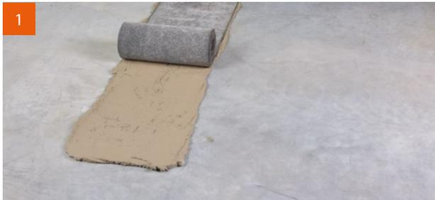
1 Auf die Bodenplatte wird eine Bitumenpappe auf Mörtel verlegt.
