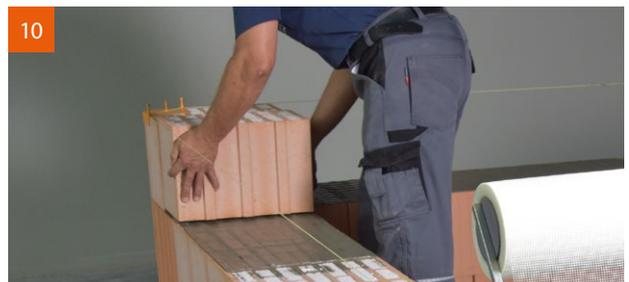
10 Einfaches knirsches Versetzen des Planziegels.
