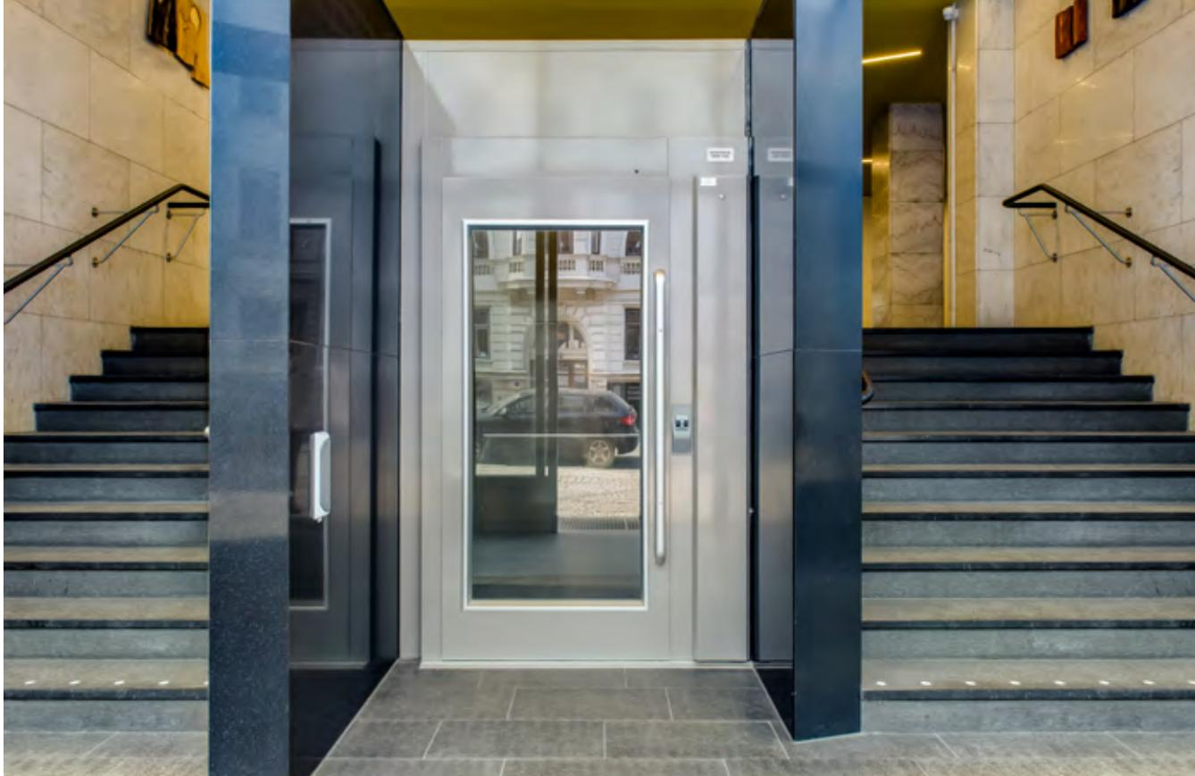
Das Modell HIRO A4 wurde im Treppeneingang eines Universitätsgebäudes installiert. Der Architekt wählte dieses Aufzugsmodell aufgrund der niedrigen Schachtgrube, der kleinen Stellfläche und des eleganten Designs.
