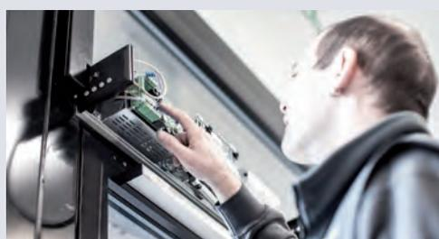
Ein externes Steuermodul oder ein Laptop ist nicht notwendig. Das macht den ETS speziell für Montage- und Servicefirmen interessant, die nicht für jeden Antriebstyp ein eigenes externes Programmiergerät bzw. eine spezielle Software beziehen wollen.
