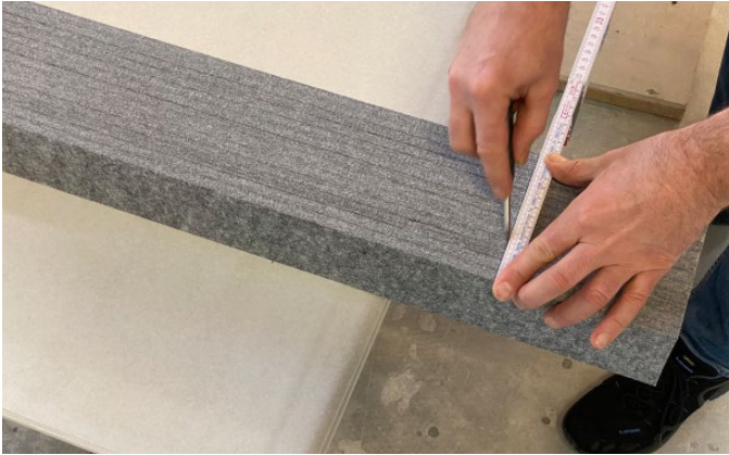
Bild 1: Ausmessen und Anzeichnen Überstand
