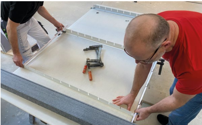
Bild 2: Auflegen und Fixieren der Befestigungsschienen
