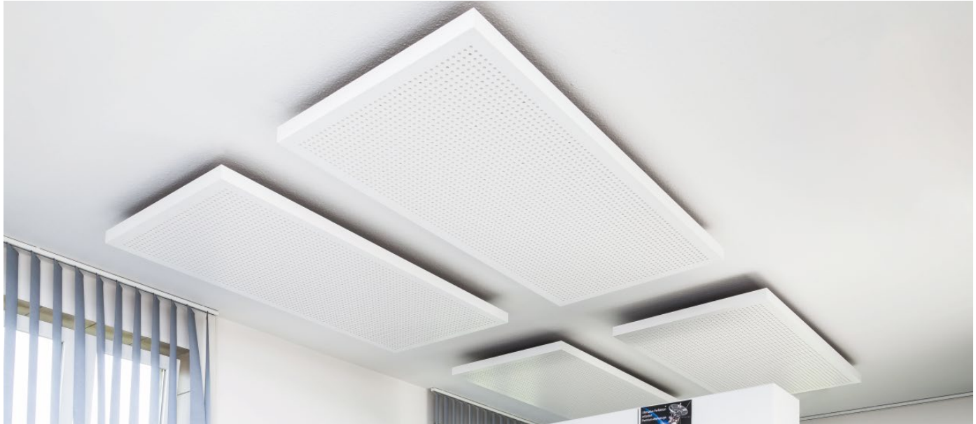
Objekt: SorTec Pharma Sortiertechnik GmbH, Wolpertshausen
