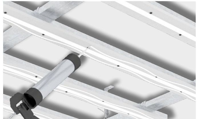
Bild 5: Auftragen Montagekleber
