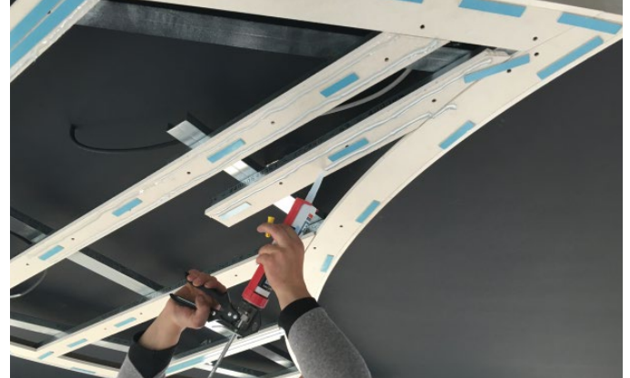
Bild 3: Auftragen Montagekleber
