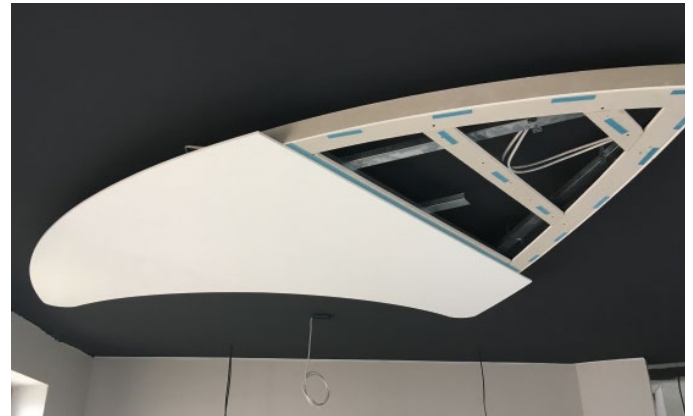
Bild 4: Aufkleben Cleaneo Smart 10
