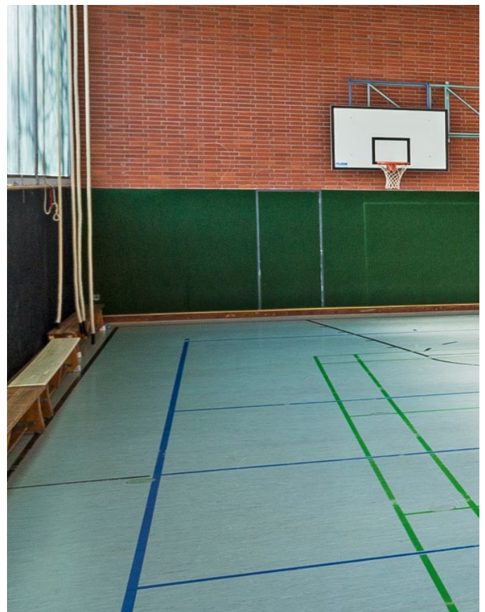
Mögliches Beispielobjekt: Sporthalle
