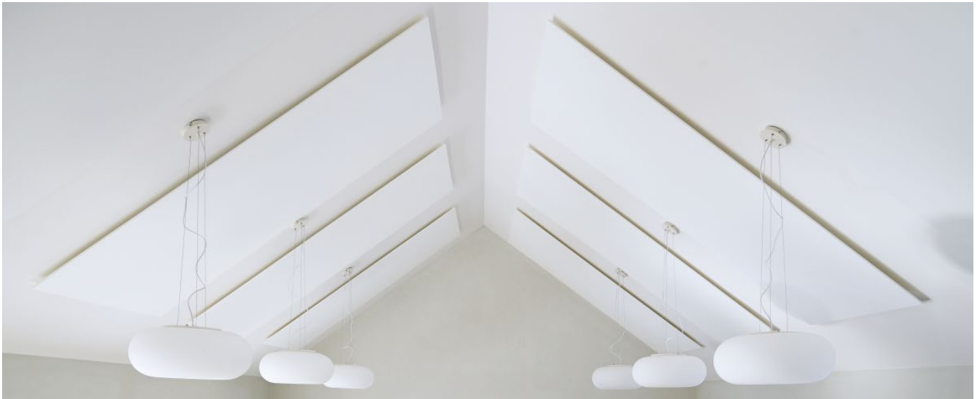
Objekt: Gemeindehalle, Jork
