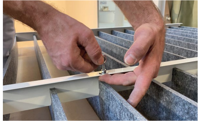
Bild 4: Anbringen Befestigungsmittel
