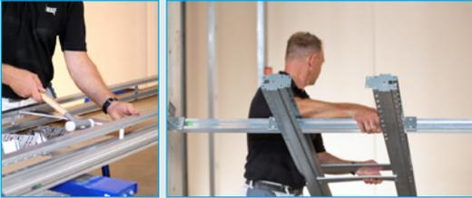
**1** Ständerprofile mit den Traversen **einfach vormontieren** und am Stück in die Wandkonstruktion einstellen
