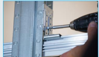
**6** Schrauben ermöglichen **exaktes Justieren** der Höhe vor dem Festschrauben
