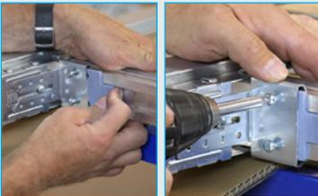
**4** Ein Montageclip sichert die Position für das Anschrauben der Tragschiene
