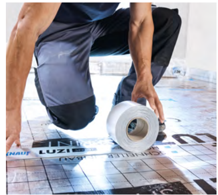
Kopfstöbe am besten mit Luzi Sprint Anschlussstreifen abdichten
