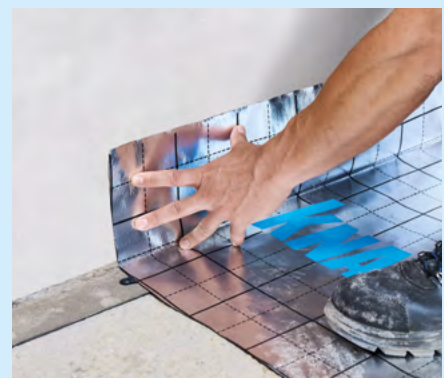
Bei Mauersperrbahnen auf der ersten Steinlage ist es sinnvoll, Luzi Sprint bis zur Oberkante des Fußbodens hochzuziehen
