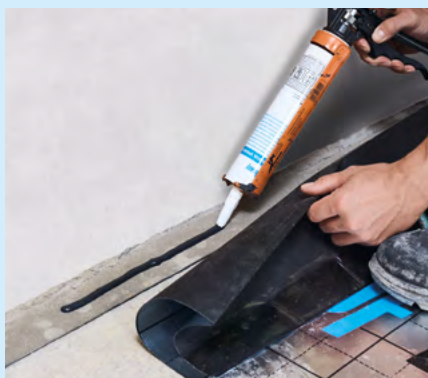
Bei Mauersperrbahnen auf der Bodenplatte verkleben Sie die Abdichtungsbahn am besten mit Luzi Sprint Anschlussstreifen oder Katja Sprint Anschlussfix
