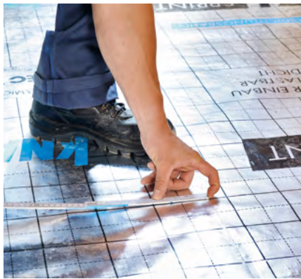
Ausgerollte Bahnen mit 5 cm Überlappung an Längsstoß verlegen
