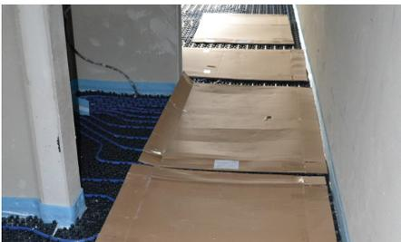
**4** Belastungen durch Begehen, das Aufstellen von Leitern, Gerüsten oder das Abstellen von Geräten und Lasten auf den Systemplatten ist zu unterlassen. Sofern es ständige Gehwege im Objekt geben sollte, oder Geräte wie z.B. Abrollhaspel zwingend im Objekt aufgestellt werden müssen, so sind diese Bereiche besonders abzudecken und zu schützen, damit ein Eindrücken oder eine Beschädigung der Noppen ausgeschlossen ist.
