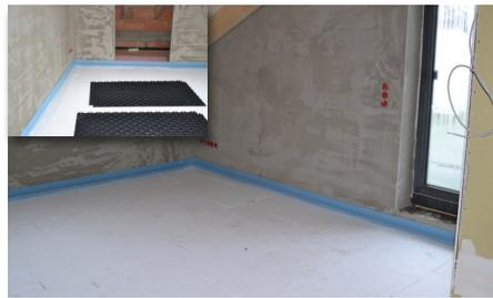
**2** Randdämmstreifen an allen aufsteigenden Bauteilen anbringen. Den an dem Randdämmstreifen befindlichen Folienfuß auf der oberen Dämmlage bzw. dem vorhandenen Untergrund auflegen. Bei der Verwendung von gebundenen Schüttungen unter der Systemnoppenplatte empfehlen wir eine Trennlage als Schutzfolie/Trennschicht aus PE (Polyethylen) mit einer Dicke von mind. 0,15 mm und einer Überlappung von 10 cm einzubauen.
