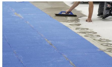
**8** Verlegen der Belagträger- und Entkopplungsmatte BLANKE PERMAT mit Dünnbettmörtel C2 S1 nach DIN 12004 bzw. 12002.
