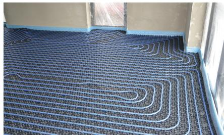
**5** BLANKE BF/C PIPE in einem Verlegeabstand entsprechend der Planung und der Berechnung des Flächenheiz- und Kühlsystems auf dem vorgegebenen Raster schnecken- oder mäanderförmig in der Systemplatte verlegen. Der geringste Verlegeabstand (VA) beträgt 10 cm, der maximale Verlegeabstand 25 cm. Der Mindestbiegeradius des PE-RT Heizrohres 16 x 2 mm von 8 cm (90° Umlenkung) bzw. 16 cm (180° Umlenkung) darf nicht unterschritten werden.
