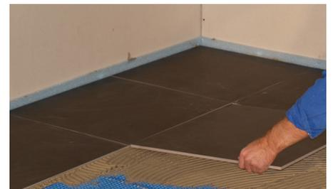
**9** Verlegen der Fliesen auf dem Belagträger. Zur Verlegung der BLANKE PERMAT und der Fliesen ist ein Dünnbettmörtel C2 S1 nach DIN 12004 bzw. 12002 zu verwenden. Bei Natursteinen ist ein darauf abgestimmter und geeigneter Dünnbettmörtel zu verwenden.
