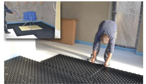
**3** Die Systemnoppenplatten sind 50 mm überlappend zu verlegen und im Bereich der zweiseitigen Überlappung der Systemplatten, können diese in einander geklickt werden (Druckknopftechnik). **Die fertig verlegten Systemnoppenplatten sind generell direkt nach dem Auslegen zu schützen!**
