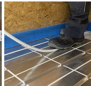
Geringe Aufbauhöhe trotz integrierter Wärmedämmung und Entkopplung, auf regenerative Wärmeerzeuger abgestimmter Rohrabstand und reduzierter Rohstoffeinsatz, das sind die produktspezifischen Eigenschaften des neuen und besonders wirtschaftlichen Flächenheiz- und -Kühlsystems BLANKE PERMATOP ECO.
