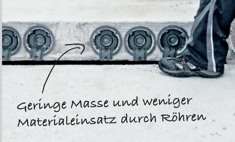
*Geringe Masse und weniger Materialeinsatz durch Röhren*
