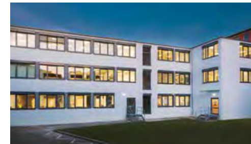
Stuttgart , 3-geschossiges Bürogebäude, BGF 4.910 m 2
