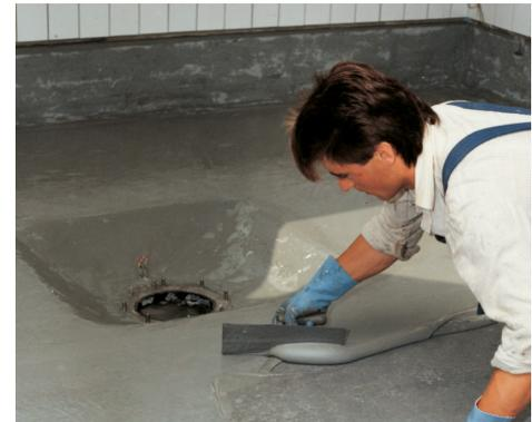
Auftragen von PCI Apoflex F zum Abdichten unter dem Keramikbelag einer Großküche.
