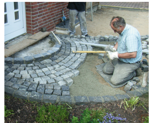
Verlegen von Kleinpflaster in PCI Pavifix DM.
