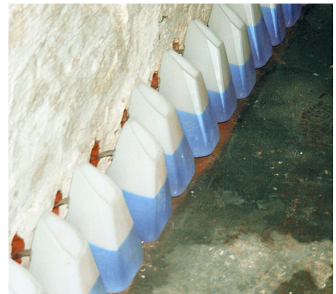
PCI Barra Gisol wird mindestens 24 Stunden lang aus PCI Injektionsbehältern injiziert.
