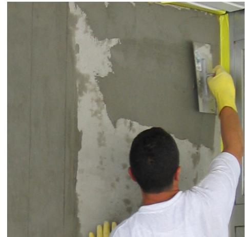
PCI Barrafill L für Kosmetikarbeiten an Betonbauteilen.
