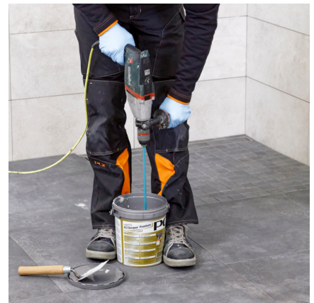
Gründlich Mischen. Um eine homogene Mischung zu gewährleisten, sollte das Gebinde umgetopft und nochmals vermisch werden.
