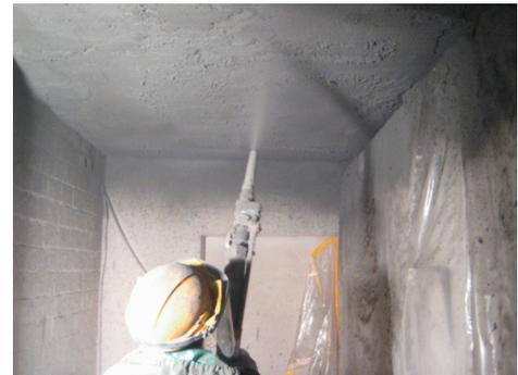
Aufgrund seiner exzellent guten Anhaftungseigenschaften besticht PCI Nanocret R3 bei Überkopf-Anwendungen, sowohl händisch als auch maschinell verarbeitet.
