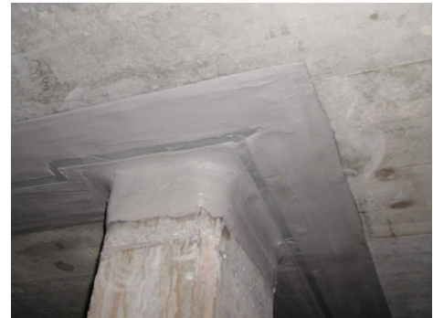
PCI Pectape 3000 - Abdichtungsband mit PCI Barrafix EP verklebt.
