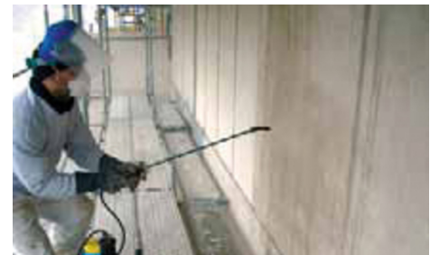
Die Hydrophobierung PCI Silconal 328 wird im Spritzverfahren oder durch sattes Fluten aufgebracht.
