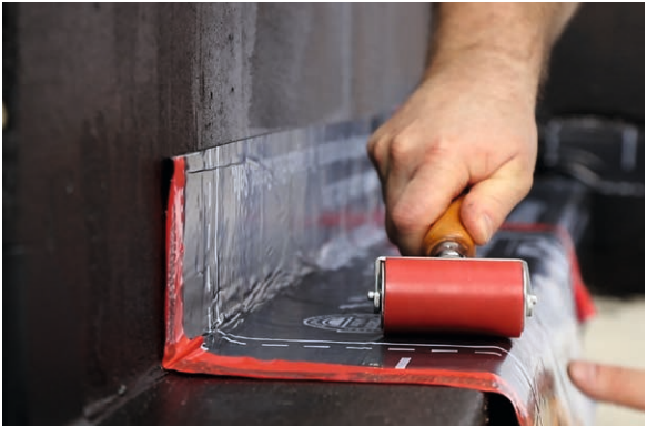
Einfach ankleben: Sauberes, schnelles Verarbeiten zeichnet PCI Pecithene 1000 aus. Auch Ecken und Unebenheiten lassen sich mit der Dichtbahn einfach ausführen.
