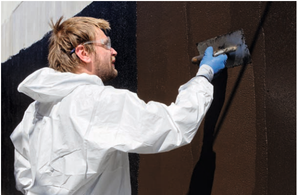
PCI Pecimor 2K eignet sich auch bei drückendem Wasser und aufstauendem Sickerwasser bis 3 m.
