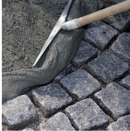
PCI Pavifix CEM Rapid mit einem Gummischieber in die Fugen einarbeiten. Die Belagsoberfläche mit einem leichten Sprühstrahl feucht halten.
