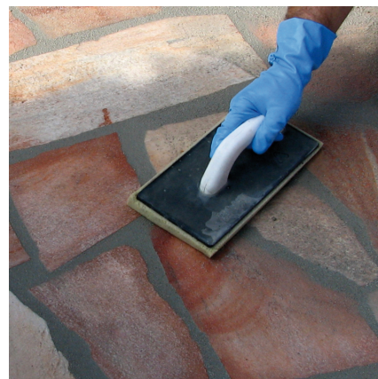
Anschließend Plattenbelag mit einem Schwammbrett nachwaschen.
