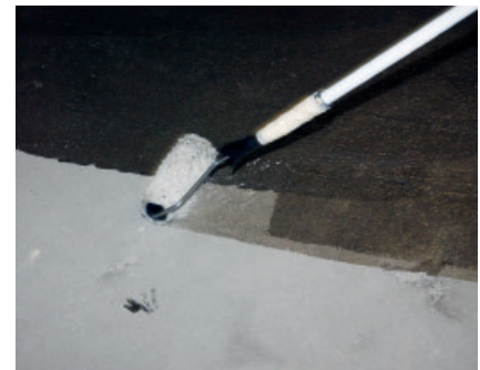
PCI Epoxigrund 390 wird in den vorbereiteten Untergrund z.B. mit einer Flächen/Malerwalze eingearbeitet.
