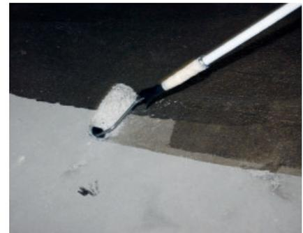
PCI Epoxigrund 390 bzw. PCI Epoxigrund Rapid wird in den vorbehandelten Untergrund z.B. mit einer Flächen/Malerwalze eingearbeitet.
