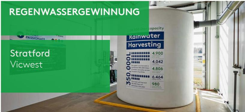
Seit Januar 2023 sammelt das System zur Regenwassergewinnung in Stratford Regenwasser. Das gesammelte Regenwasser wird für die Versorgung der Toiletten der Anlage verwendet, wodurch der Verbrauch aus dem städtischen Wassersystem gesenkt wird.
