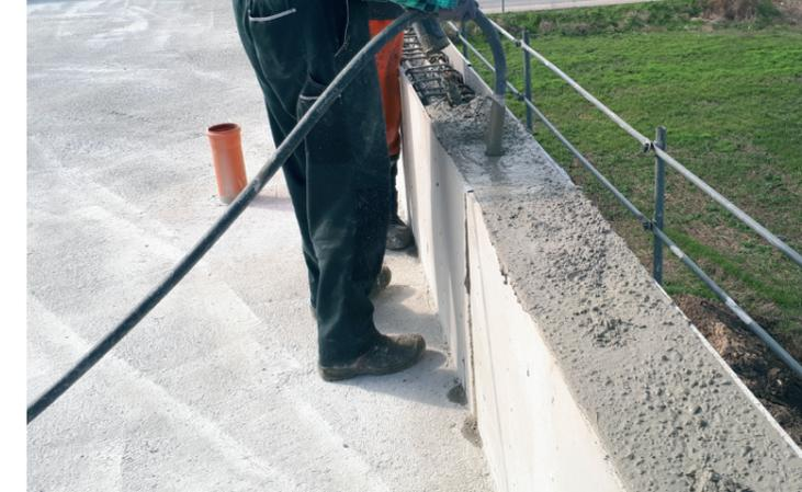
Diese kraftvolle Ringbalkenschalung ist mittlerweile ein Klassiker aus dem Schalungsprogramm von MAKO und auf Baustellen nicht mehr wegzudenken. Die Stabilität ist beispiellos! Dennoch muss nicht auf Technik oder Funktionalität verzichtet werden, da individuell auf Höhe gefertigte U-Bügel für eine form- und kraftschlüssige Verbindung mit dem Beton sorgen und verzinkte Rundstahlklammern zur Abspannung die notwendige Sicherheit bieten.
