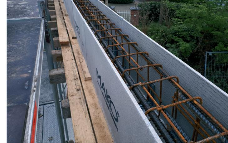
Dank dieser Schalung von MAKO ist es möglich, auch Deckenversprünge schnell und effektiv zu schalen. Dabei wurde bei der Entwicklung dieser verlorenen Schalung größter Wert darauf gelegt, die Arbeitsschritte am Bau deutlich zu minimieren. Unternehmer und Anwender können daher vor allem auf kostenaufwendige und projektspezifische Konstruktionen verzichten. So wird für ganze Bauabläufe die Wirtschaftlichkeit gesteigert.
