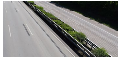
Entwässerung zum Mittelstreifen
