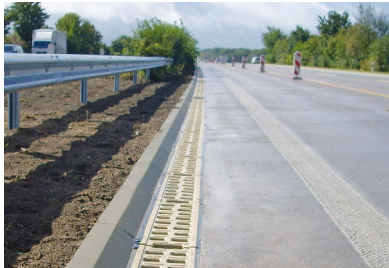
bisher: Entwässerung über Rinne + Betonboard
