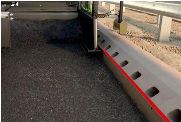
Minimierung Schmutzeintrag während der Bauphase
