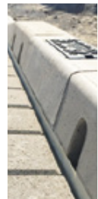
■ Klebeband schützt während des gesamten Einbaus
