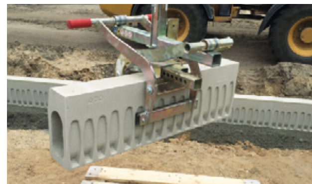
■ Zangen erleichtern das Versetzen der Elemente
