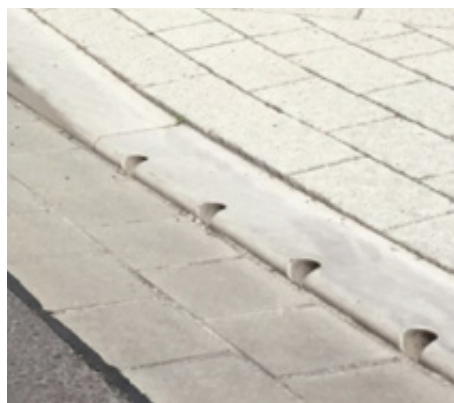
Mittelsteine mit Einlauföffnungen
