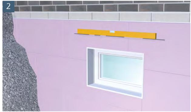
2 Oberkante Lichtschacht anzeichnen. Ggf. ACO Bohrschablone nutzen (Oberkante der Bohrschablone = Oberkante Lichtschacht). Der Abstand zwischen Fensterbank und Lichtschachtboden sollte mindestens 15 cm betragen
