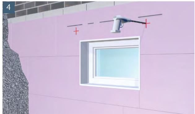
4 Obere Befestigungslöcher ggf. durch Perimeterdämmung hindurch bohren und von Bohrstaub befreien
