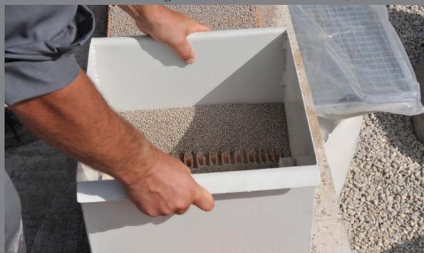
Mittels Granulatschlitten, der über die Ziegeln geschoben wird, erfolgt das Verfüllen mühelos.
