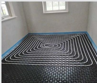
In Kombination mit **GEOCELL® Schaumglas**, welcher für den groben Niveausgleich eingesetzt wird, ist dies eine einfache, trockene, feuchteresistente und unbrennbare Lösung für den Neuaufbau von Fußböden.
