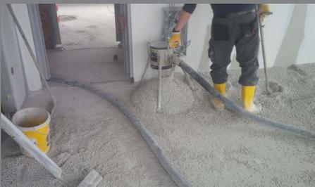
Fördern und Einbringen mit der Estrichpumpe
