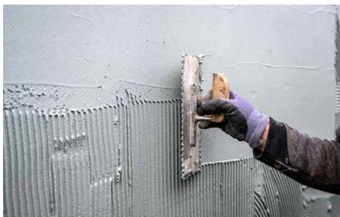
12 Die aufgetragenen Abdichtungsschichten werden jeweils nach dem Aufzählen wieder geglättet.
