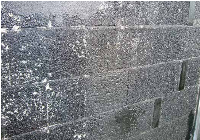
1 Wandfläche vorbereitet mit SoproThene® Voranstrich.
