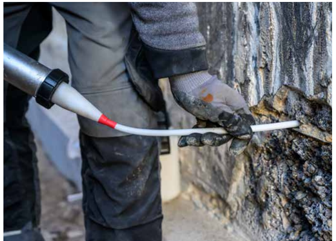
Sopro Verkieselung Gel wird in das zu sanierende Mauerwerk mit Hilfe einer Schlauchbeutelpresse sowie den beiliegenden Injektionsspitzen in die Bohrlöcher eingebracht.
