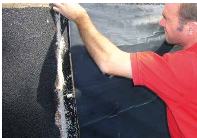
10 Ansetzen der SoproThene® an der Kellerwand.
