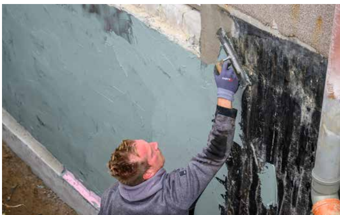
7 Die Abdichtungsarbeiten werden bis zum Sockelbereich ausgeführt.
