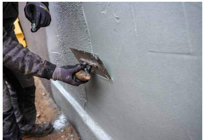
Die Abdichtungsschicht wird nach dem Auftrag geglättet.
