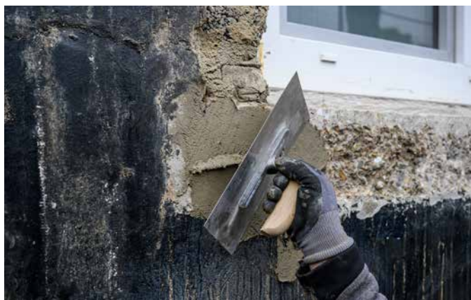
Ausbrücke am Mauerwerk, z. B. im Bereich neu eingebauter Kellerfenster, werden mit Sopro RAM 3® geschlossen.
