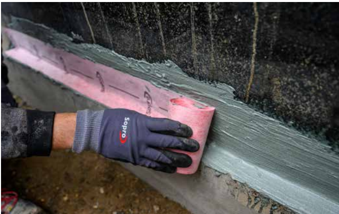
3 Sopro AEB® Dichtband wird in eine vollflächige Schicht aus ZR Turbo MAXX eingelegt ...
