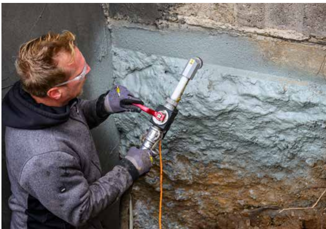
Auch auf unebenen Untergründen kann die Spritztechnik problemlos eingesetzt werden, um Flächen abzudichten.
