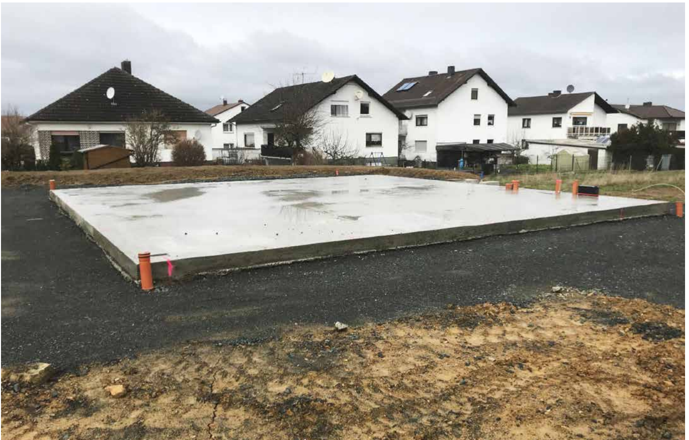
Bodenplatten ohne Unterkellerung.
