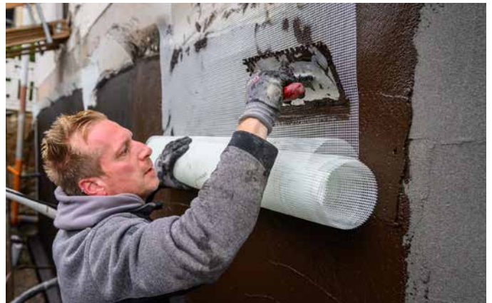
4 In die erste Abdichtungsschicht wird – je nach Voraussetzungen – Sopro KellerDicht-Armierung eingearbeitet.
