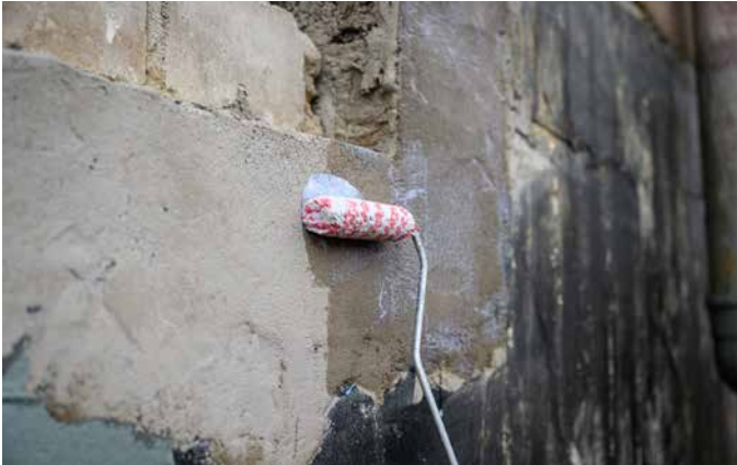
1 Saugende Untergründe, z. B. im Bereich von Ausgleichsspachtelungen, werden mit Sopro Grundierung vorbehandelt.
