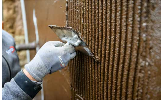
2 Die Schicht aus ZR Turbo MAXX kann nach Durchtrocknung mit Sopro KMB Flex Poly 2-K überarbeitet werden.
