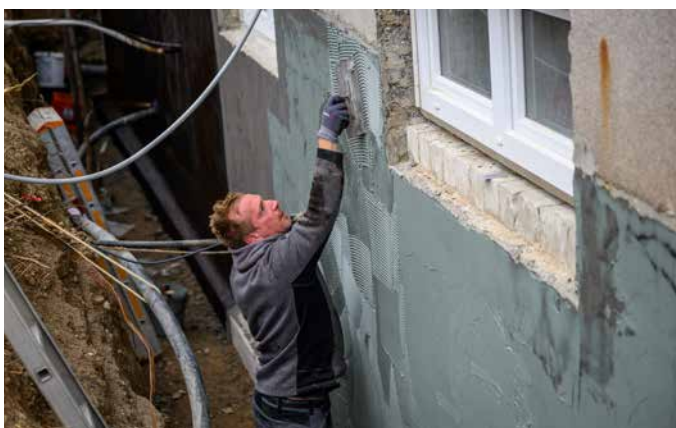
11 Die Abdichtungsschicht wird an die Bereiche von Kellerfenstern herangeführt. Diese werden im Nachgang in die Flächenabdichtung eingedichtet.
