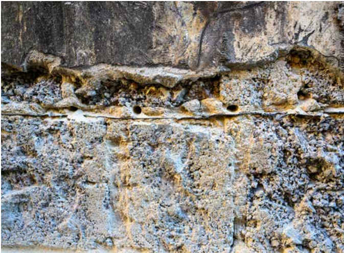
Die Bohrlöcher werden in einem Abstand von max. 12 cm ausgeführt (mind. 10 cm über Sockelhöhe). Die Bohrung erfolgt jeweils waagrecht in den Lagerfugen.
