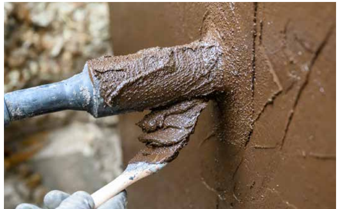
4 Die Rohr- oder Kabeldurchführungen im Nachgang mit Sopro KMB Flex 2-K Poly überarbeiten.
