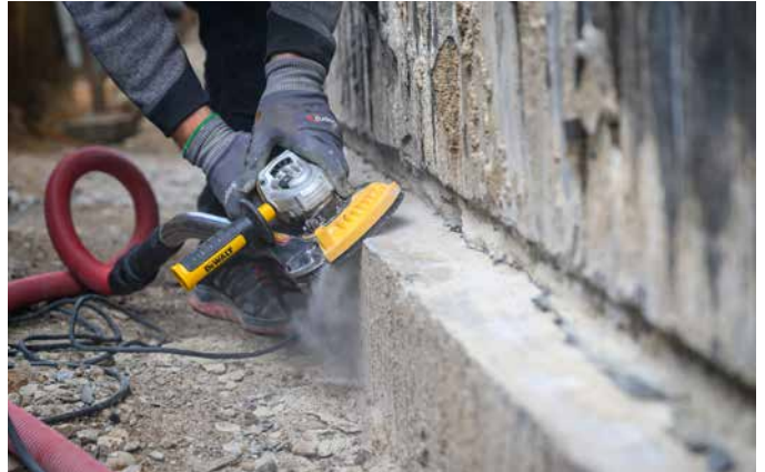
Scharfe Außenecken sind vor dem Überarbeiten zu brechen bzw. maschinell, z. B. mit einem Winkelschleifer, anzufassen.
