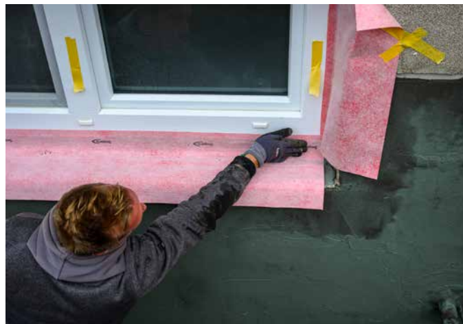
8 Das Sopro RahmenDichtband wird vollflächig in der Schicht aus Sopro ZR Turbo MAXX verklebt und angedrückt.
