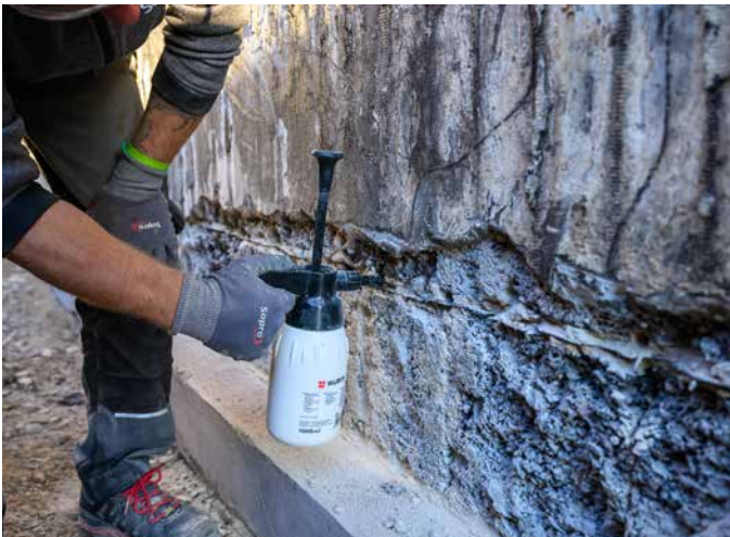
Je nach Durchfeuchtung des Mauerwerks werden die Löcher vor dem Verfüllen mit Sopro Verkieselung Gel leicht angehätsst, um eine gleichmäßige Verteilung der Horizontalsperre zu ermöglichen.
