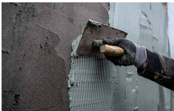
10 Nach Durchtrocknung der ersten Abdichtungsschicht kann die zweite Schicht ZR Turbo MAXX aufgetragen werden.
