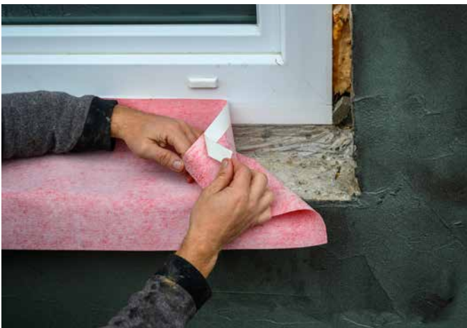
3 Sopro RahmenDichtband passgenau, falten- und spannungsfrei ankleben.
