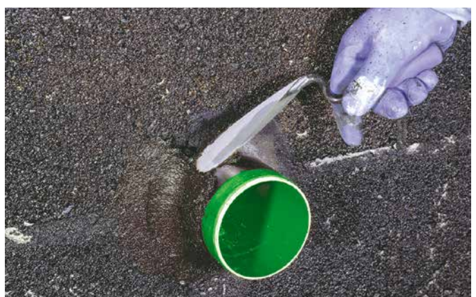
4 Nach Trocknung des Voranstriches bzw. der Grundierung wird das Rohr mit der Bitumendickbeschichtung überzogen. Auch dieser Auftrag erfolgt in zwei Schichten.
