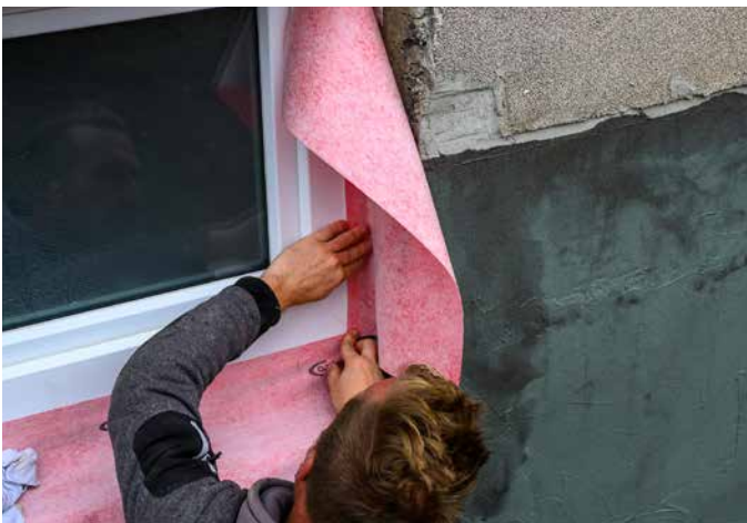
5 Angrenzende Dichtbänder werden überlappend verklebt.
