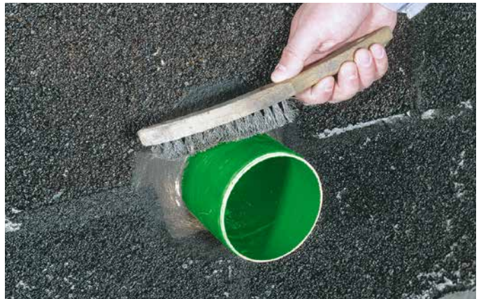
2 Nach Aushärtung der Hohl-/Dichtungskehle wird die Oberfläche des Rohres mit einer Drahtbürste oder grobem Schleifpapier aufgeraut.
