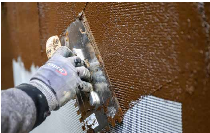
5 In die erste Abdichtungsschicht wird – je nach Voraussetzungen – Sopro KellerDicht-Armierung eingearbeitet.
