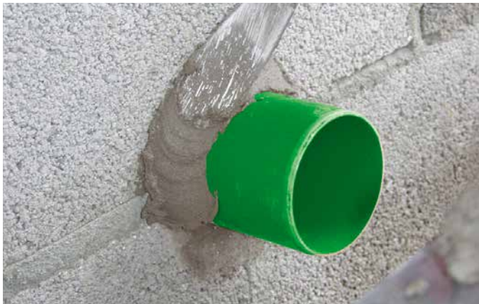
1 Zunächst wird eine Hohl-/Dichtungskehle aus Sopro RAM 3® Renovier- & Ausgleichsmörtel ausgebildet.
