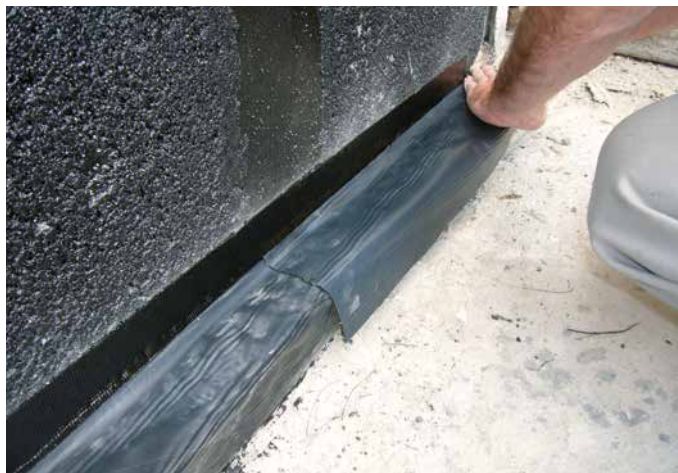
7 Die Teilstücke sind überlappend zu verkleben.
