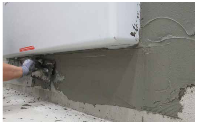
4 Die Eindichtung des Dämmelementes erfolgt umlaufend.
