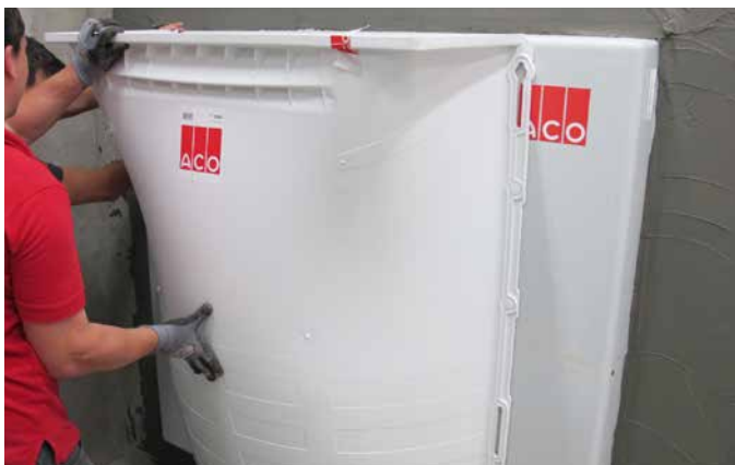
5 Nach den Abdichtungsarbeiten erfolgt die Installation des Lichtschachtes.
