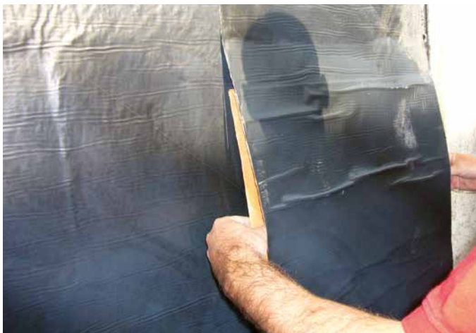
17 Ansetzen der nächsten Bahn.
