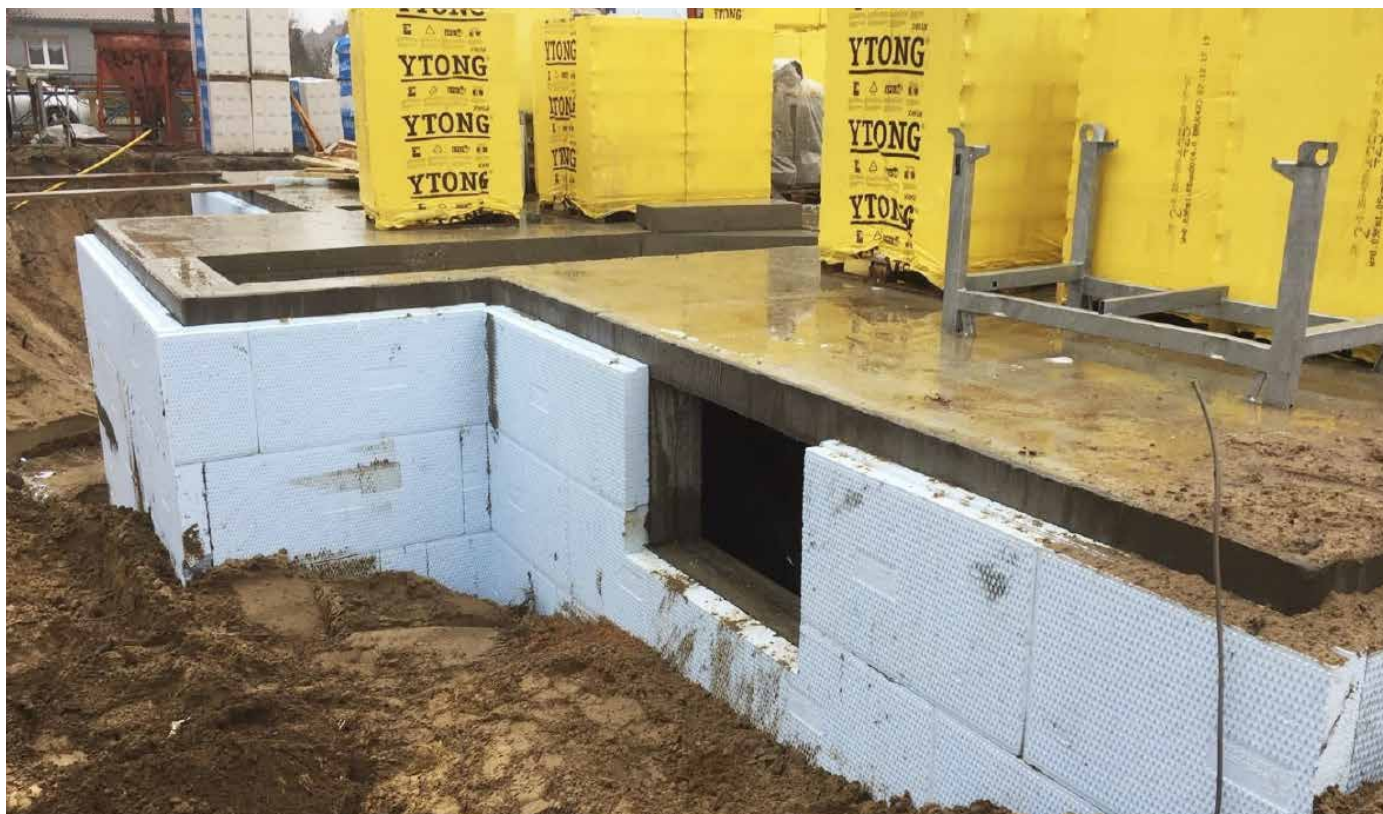
Kelleraußenwand mit Flächenabdichtung und Perimeterdämmung
