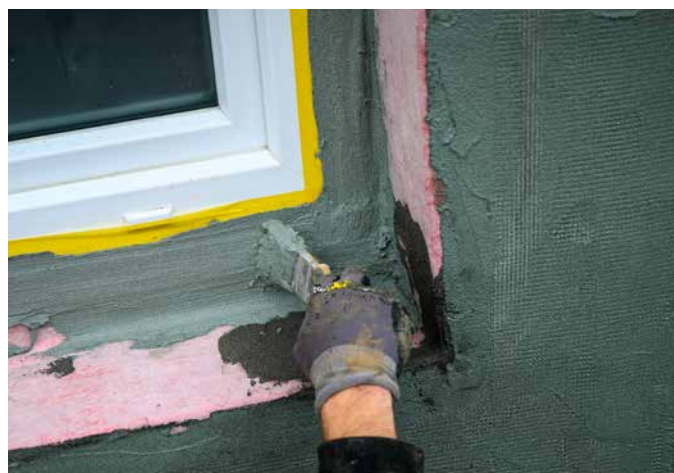
12 Das Sopro RahmenDichtband wird vollständig mit dem Abdichtungsmittel in zwei Schichten überarbeitet.
