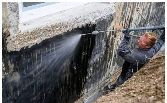
Altabdichtungen oder Anstriche werden vor der weiteren Untergrundbearbeitung von Schmutz und haftungsmindernden Stoffen gereinigt.
