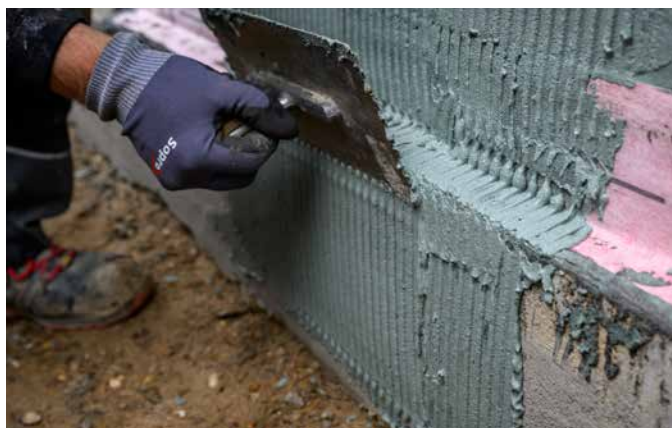
8 Der Auftrag der Abdichtungsschicht erfolgt nahtlos über den Bereich der Bodenplatte.
