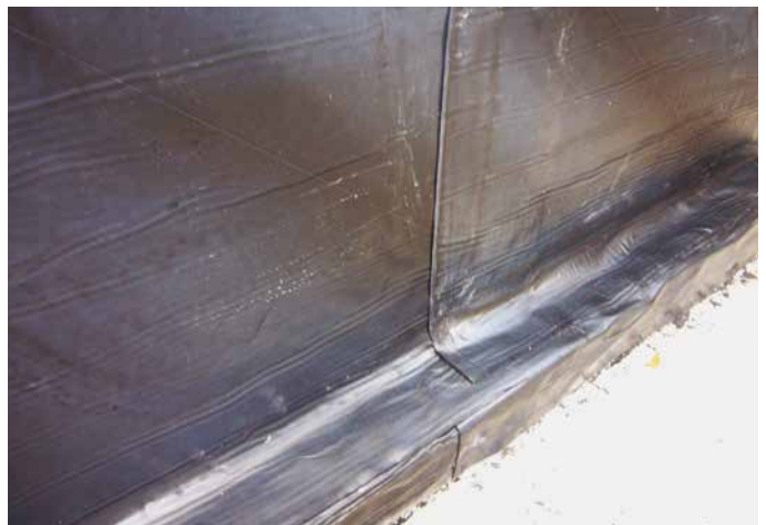
18 Abgedichtete Fläche mit Fußpunkt.
