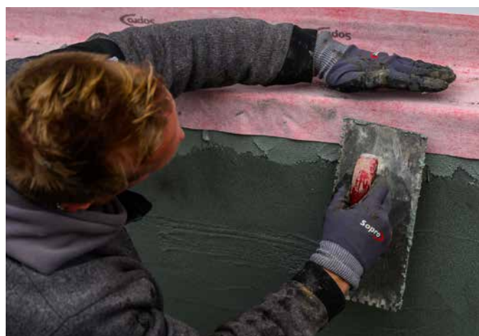
10 Bandabschlüsse faltenfrei an die Flächenabdichtung anschließen, bevor diese zweischichtig überarbeitet werden.
