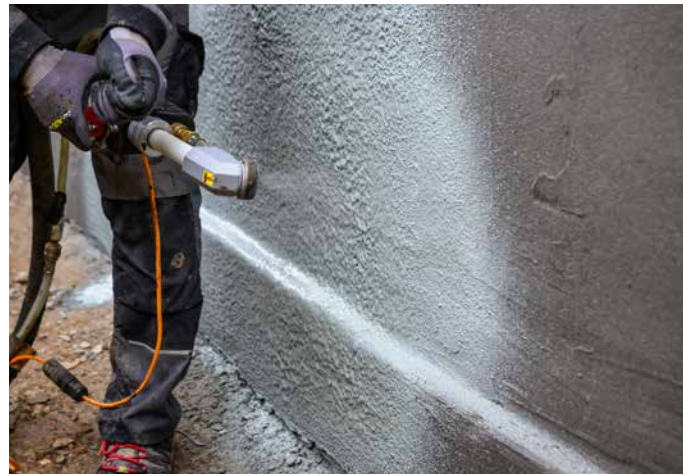
Mit Hilfe der Spritztechnik können schnelle Fortschritte bei den Abdichtungsarbeiten mit FPD erzielt werden.
