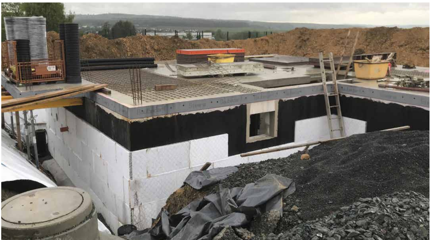
Bauwerksabdichtung mit PMBC
