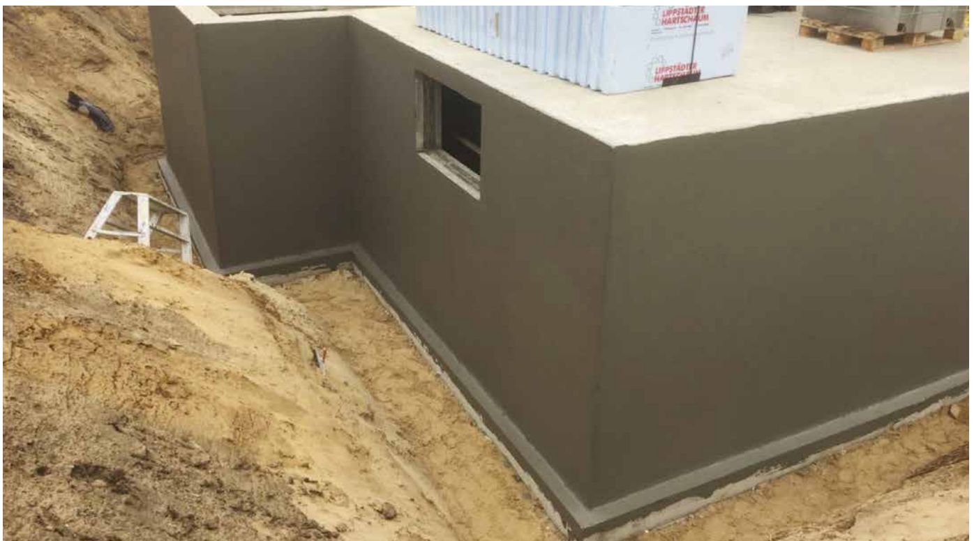
Bauwerksabdichtung mit FPD
