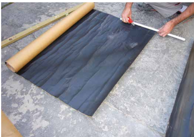
3 Zuschneiden der notwendigen SoproThene® Teilstücke.
