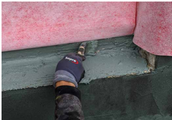
7 Alle Details unter dem Sopro AEB RahmenDichtband müssen sorgfältig mit dem Dichtbandkleber versehen werden.
