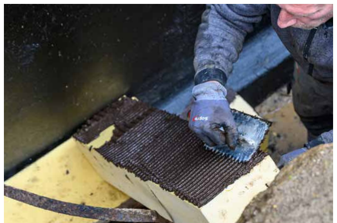
4 Als Bodenabschluss müssen kleinere Zuschnitte nach den jeweiligen Gegebenheiten des Sockels verwendet werden.
