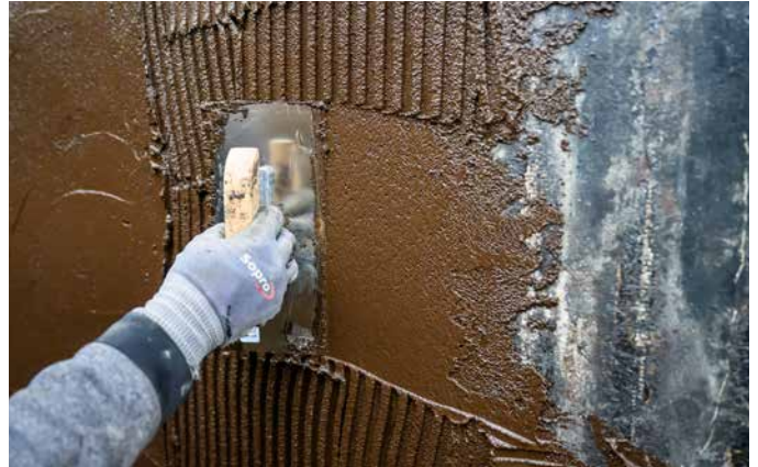
2 Die alte Bitumenabdichtung kann nach vorheriger Reinigung direkt mit Sopro KMB Flex 2-K Poly überarbeitet werden.
