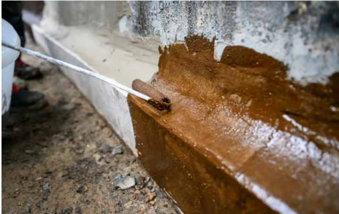
1 Saugende Untergründe, z. B. im Bereich von Ausgleichspachtelungen, werden mit Sopro BitumenVoranschicht oder Sopro KellerDichtGrundierung grundiert.
