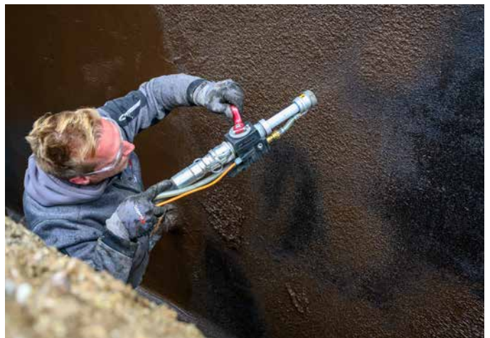
Mit Hilfe der Spritztechnik können schnelle Fortschritte bei den Abdichtungsarbeiten mit PMBC erzielt werden.
