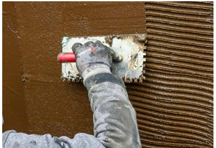
Somit können problemlos gleichmäßige Schichtstärken erreicht werden.
