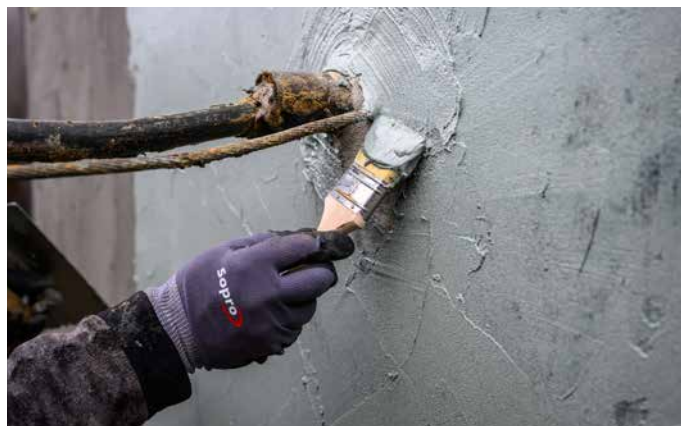
6 Freigelegte Rohr- oder Kabeldurchführungen werden sorgfältig mit Sopro ZR Turbo MAXX überarbeitet.
