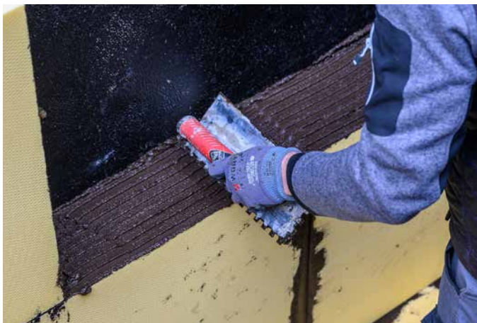
5 Im Druckwasserbereich werden die Plattenstöße vollflächig verklebt, um einem Wassereintritt hinter die Dämmung vorzubeugen.
