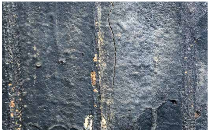
Risse in der Altabdichtung müssen ebenso im Abdichtungskonzept bzw. bei der Wahl der Materialien (z. B. Einlage eines Armierungsgewebes)) berücksichtigt werden.
