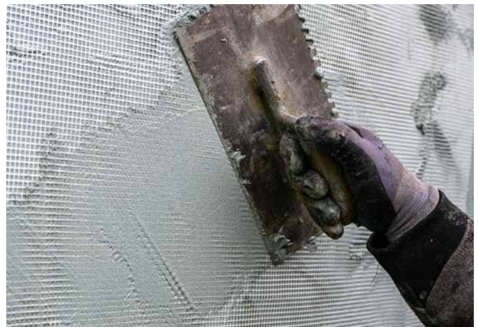
Das Armierungsgewebe wird dabei in die erste Abdichtungsschicht eingebettet und vollständig überarbeitet.
