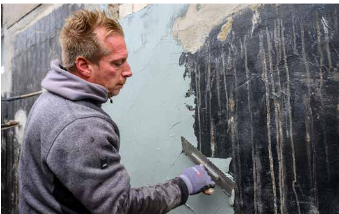
5 Die alte Abdichtungsschicht wird mit der Flächenabdichtung in zwei Schichten überarbeitet.
