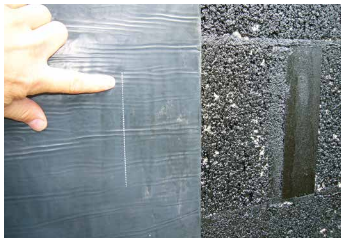
16 Arbeitserleichterung durch Überlappungsmarkierungen für die nächste Bahn.
