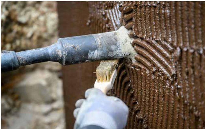
3 Freigelegte Rohr- oder Kabeldurchführungen werden vor der Überarbeitung mit einer Stahlbürste angeraut.
