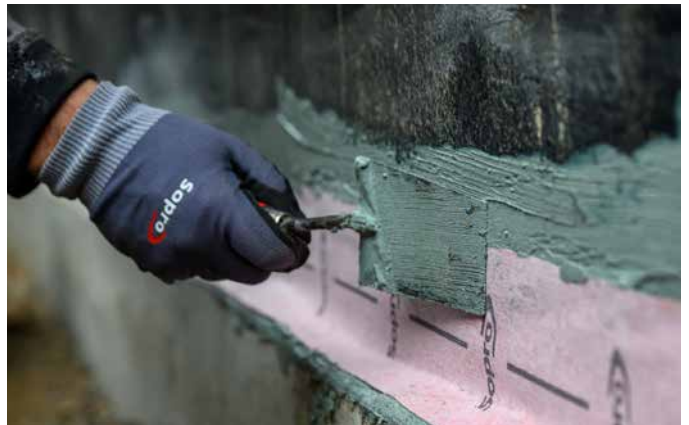
4 ... und andgedrückt. Die Dichtbänder werden vollständig überarbeitet.
