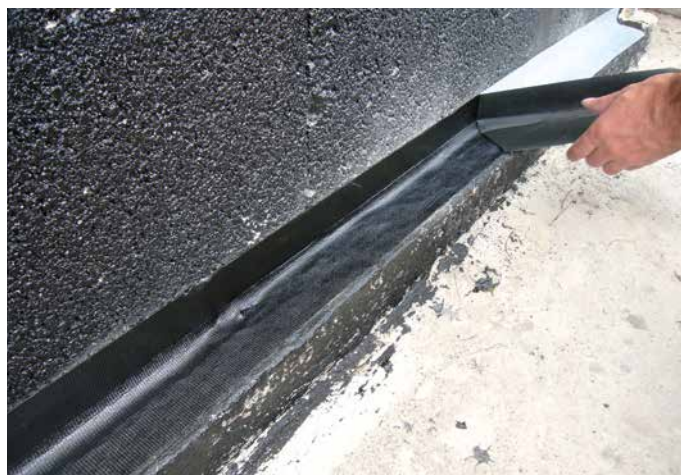
4 Abziehen der Schutzfolie vom SoproThene® Klebeband (Verschweißungsband).
