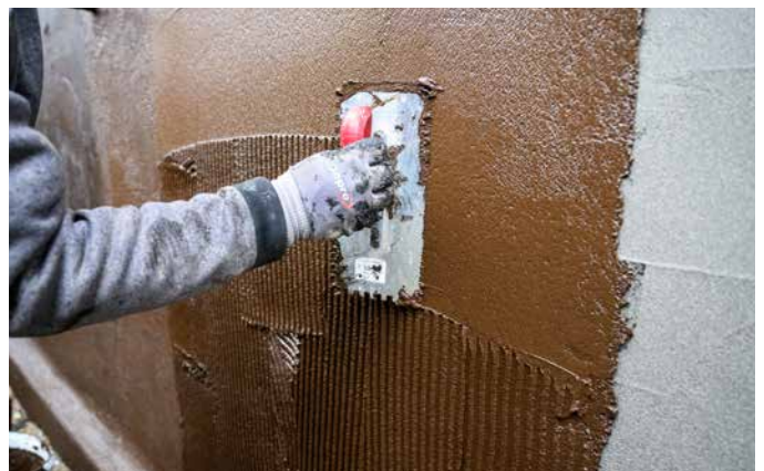
6 Die aufgetragenen Abdichtungsschichten werden dabei jeweils nach dem Aufziehen wieder geglättet.
