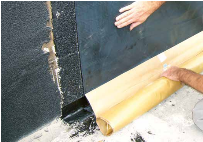
13 Andrücken der SoproThene® über die gesamte Wandfläche.
